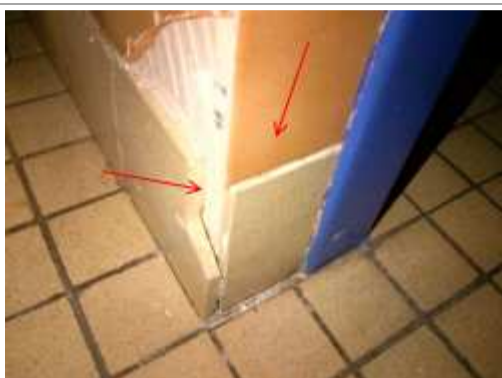
017 : Carrelage mural beige, plinthe et colle grise Bât B/06-Sanitaires H étage esc 2PRE:016
